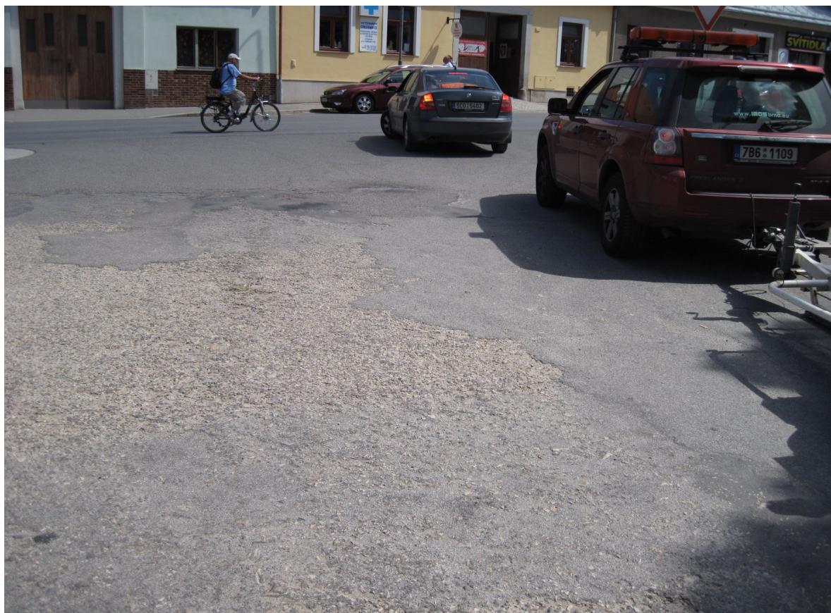
F06, km 0,292+ Koroze povrchu vozovky, vysprávký, napojení na ulici Hradecká (KÚ)
